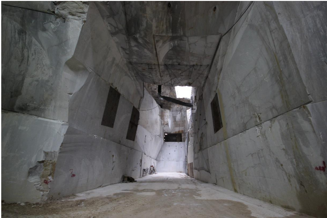
Figura 14 – Interno Cava Romana.
