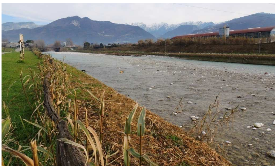
Fig. 3.2.2 L'alveo attuale del F. Frigido, regimato, al cui interno sono presenti forme mobili quali barre ghiaiose longitudinali e trasversali
