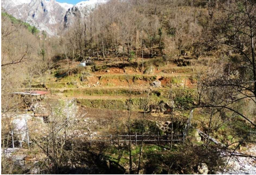
Fig. 3.2.3 Terrazzo alluvionale ghiaioso, rimodellato da interventi antropici, con depositi ghiaioso-sabbiosi alterati da suoli bruno-rossastri, Canale di Resceto.
