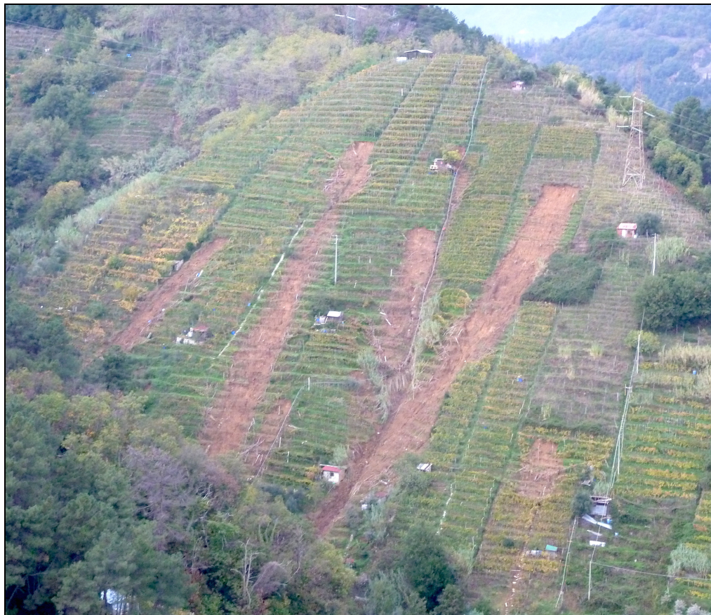
Fig. 3.3. Frane attive di colamento rapido di terra e detrito sui versanti dell'area del Monte Pretina in località Candia (Novembre 2012)
